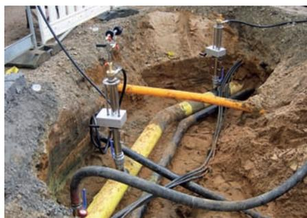
Referenzbaustelle 11.11.2009 : Sperrung einer Stahlrohrleitung DN 200 bei 3,5 bar Gasdruck für die N-Ergie (Nürnberg)
