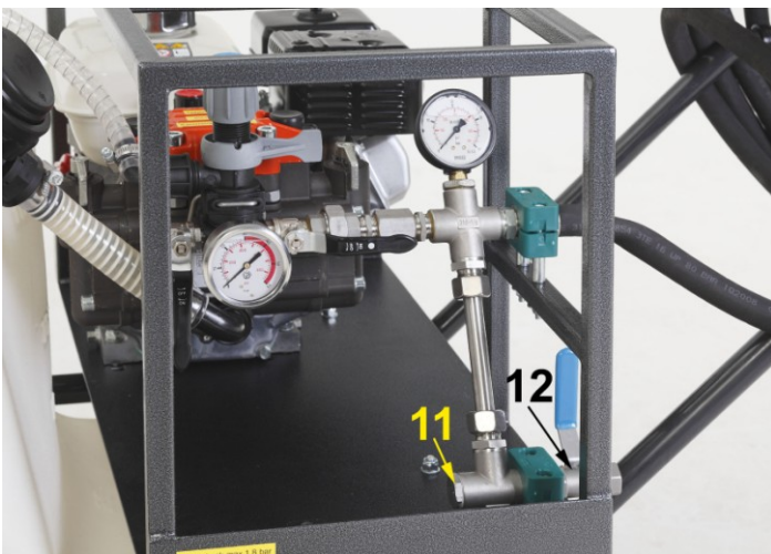
Bild 2: Pumpe ohne Magnetventil-Bypass
