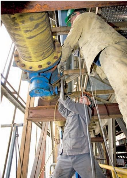
Aufgrund des eingeschränkten Bewegungsradius und der Arbeitshöhe von ca. 10 m (Rohrbrücke) war die Vorbereitung der Montage des Kugelhahns (DN 400) mit einer Baulänge von 950 mm und einem Gewicht von 800 kg besonders schweißtreibend.
